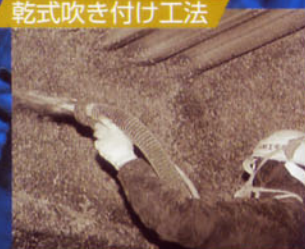
乾式吹き付け工法
