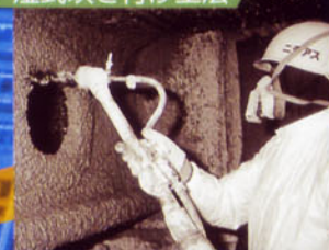
湿式吹き付け工法
