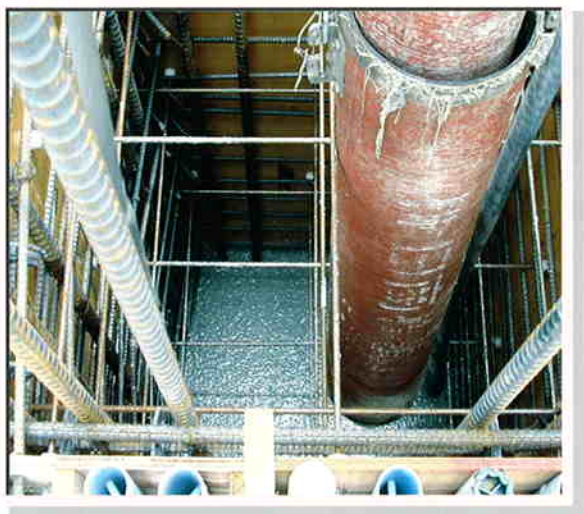
現場打ち高強度コンクリート
