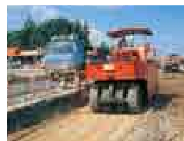
改良手順5 (転圧)
