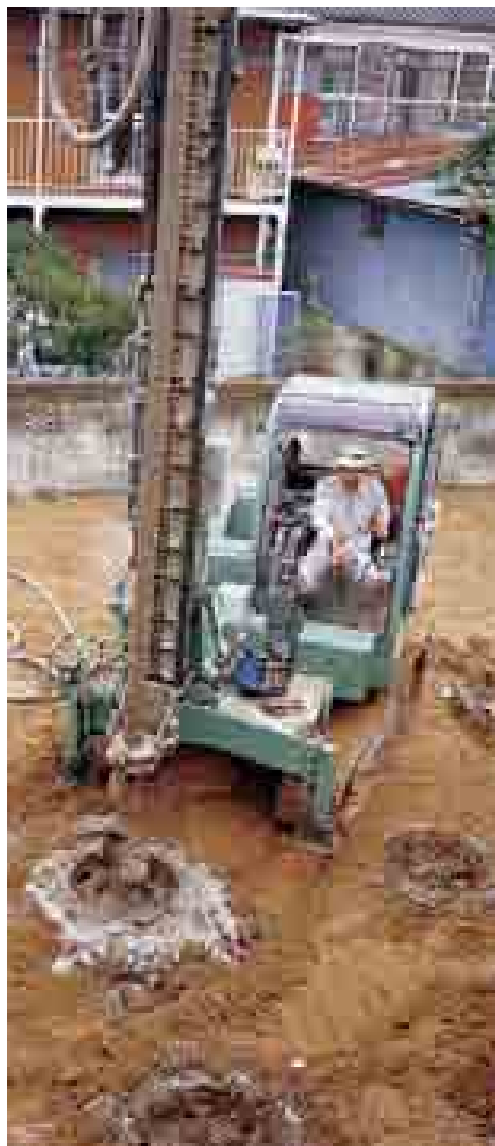
ソイルセメントコラム工法
