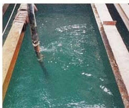
排水路補修工事(流速1.8m/sec)
