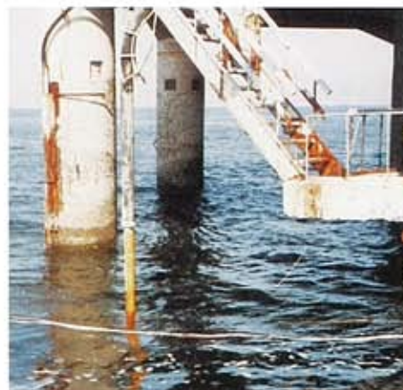
海上灯台改修工事(柱・基礎部打設)
