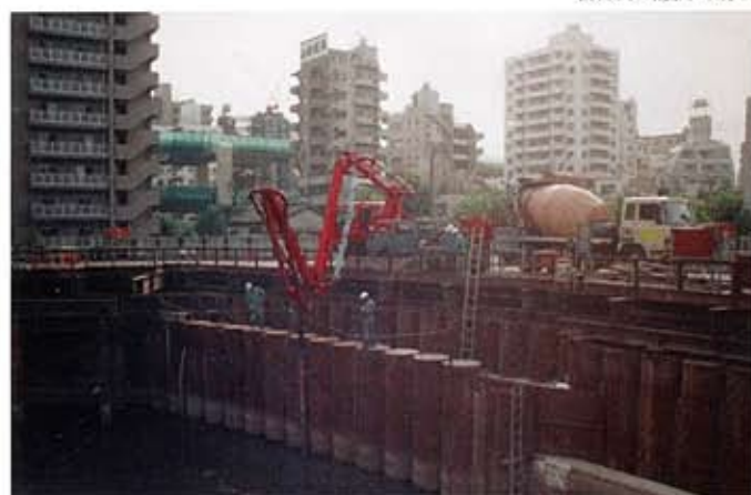
石神井川護岸改修工事
