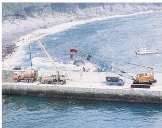
防波堤洗堀部施工状況
