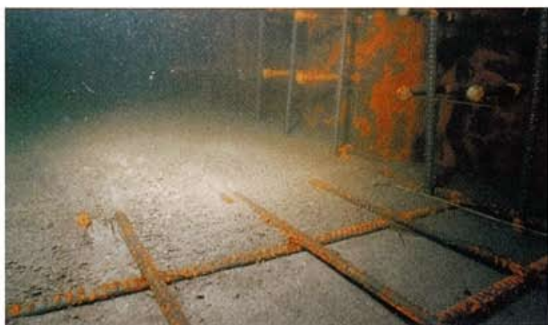
排水路底部(水中)打設状況
