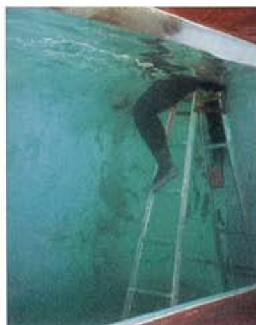
水族館水槽内部打設状況(放魚中実施)
